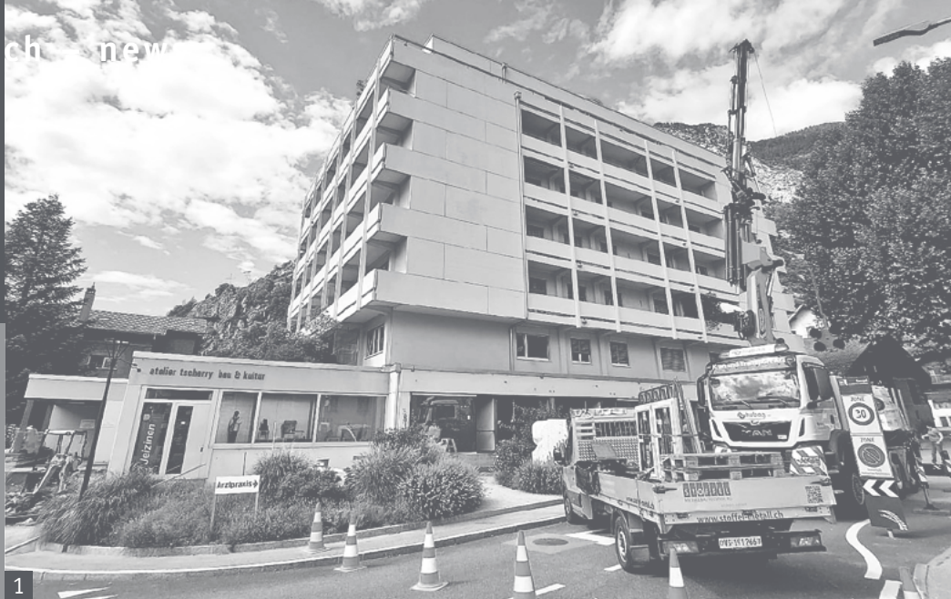
1/2 Regionales Gesundheitszentrum: Der Umbau ist in vollem Gange © Thomas Tscherry
