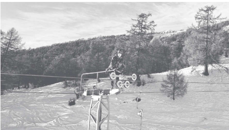
Yannick beim Wechseln einer Rolle des Bügellifts
