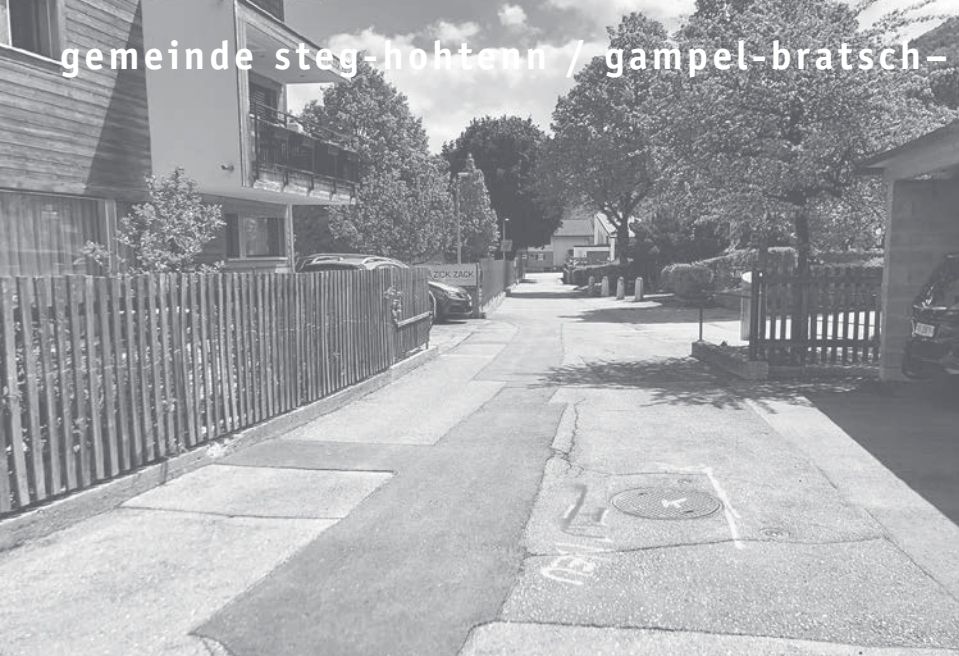
Der Fussweg in Steg wird saniert
