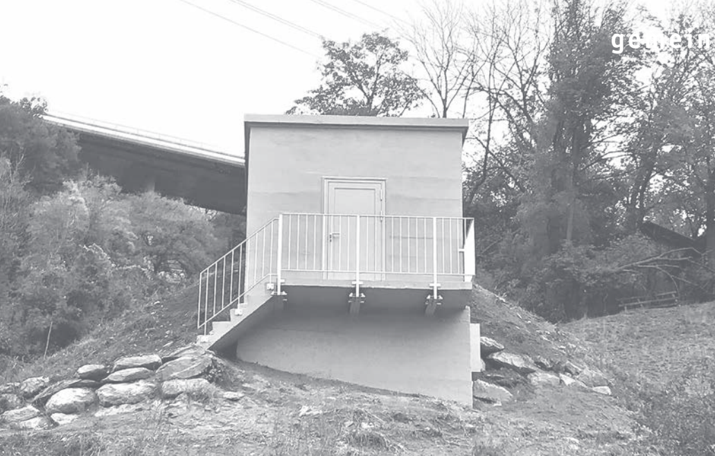
Die Sanierung des Reservoirs in Steg ist abgeschlossen
