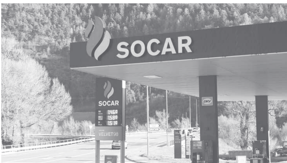
SOCAR-Tankstelle an der Bahnhofstrasse in Gampel
