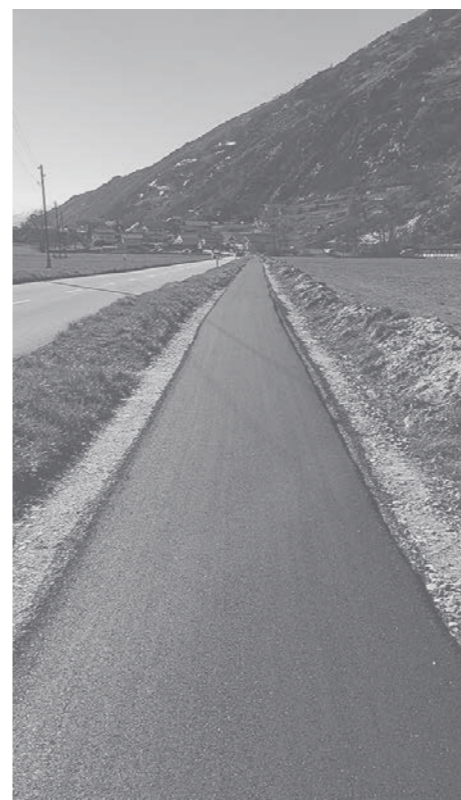
Neuer Gehweg Gampel-Niedergampel
