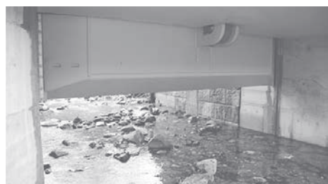
b) Detailansicht der eingebauten Schütze, Ansicht gegen die Fließrichtung
